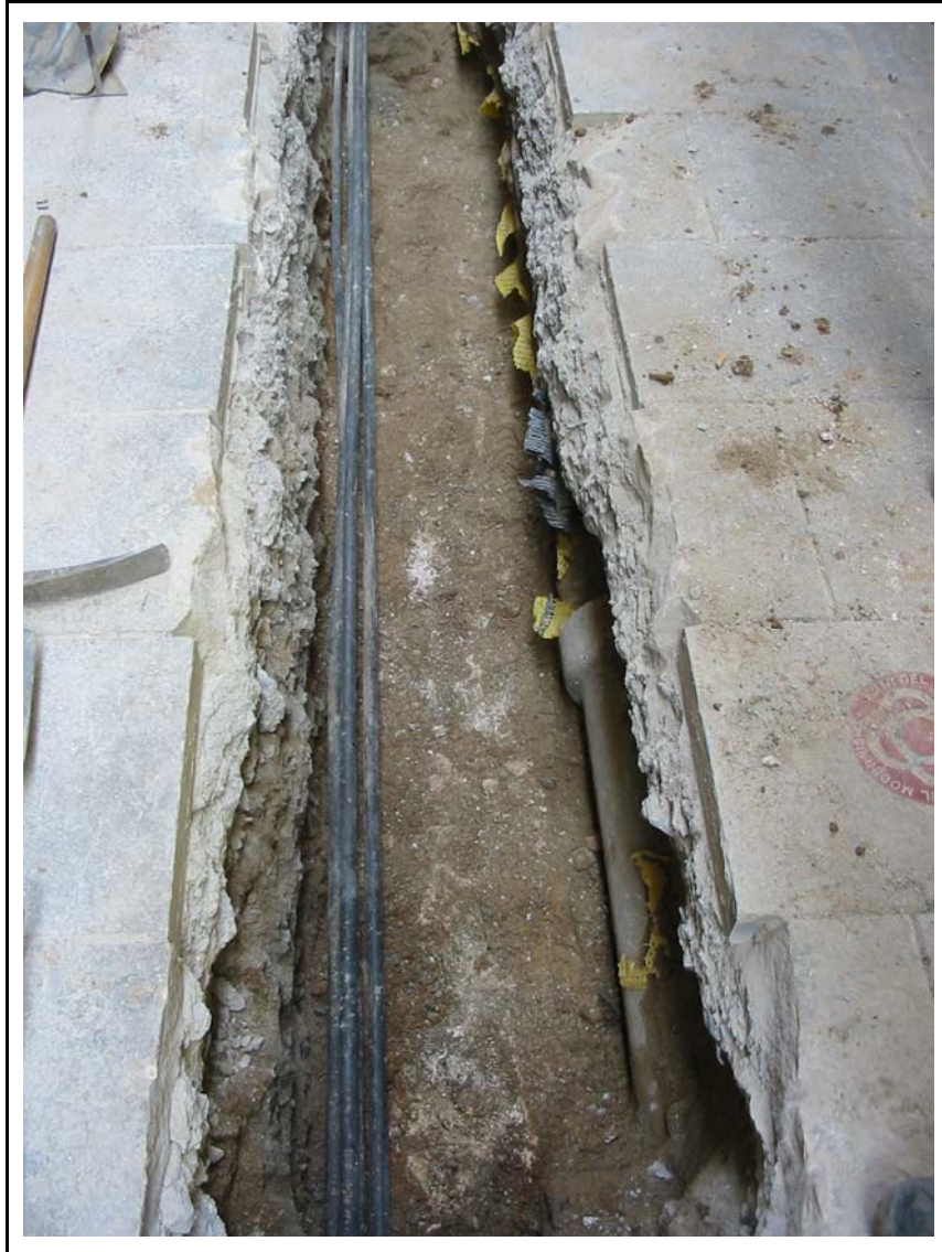
Foto 3:Rasa efectuada al carrer Montsió amb els serveis actualment en ús.
